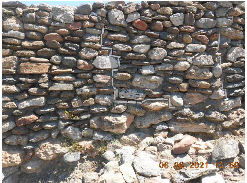
Detalle del paredón meridional ante el acceso al recinto del bastión
