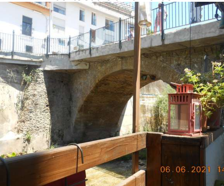
Puente sobre el río Monachil
